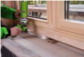
Verarbeitung des Fensteranschlusses mit FM230.
