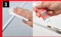
Oberflächen reinigen. DICHTKLEBER auf Glasprofil auftragen.
