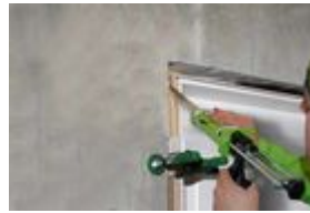
FM790 für die punktuelle Befestigung von Innen-Tür-Zargen und Holztürfuttern.
