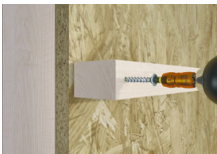
Befestigung einer Installationsebene
