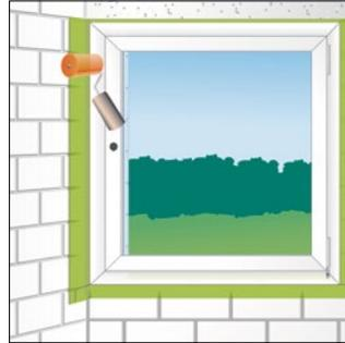
Bild 5: Folie mit einem Andruckroller anrollen
