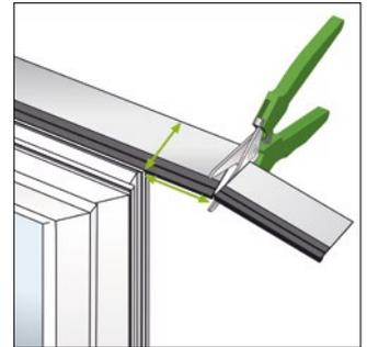
Bild 7: Folie im Eckbereich mit einem Breitenüberstand abschneiden
